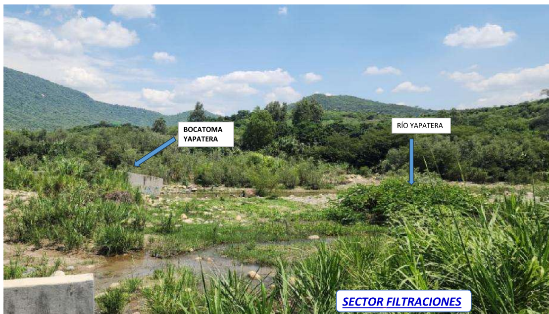
Figura N° 01: Se observa la colmatación, y vegetación en el cauce del río Yapatera
